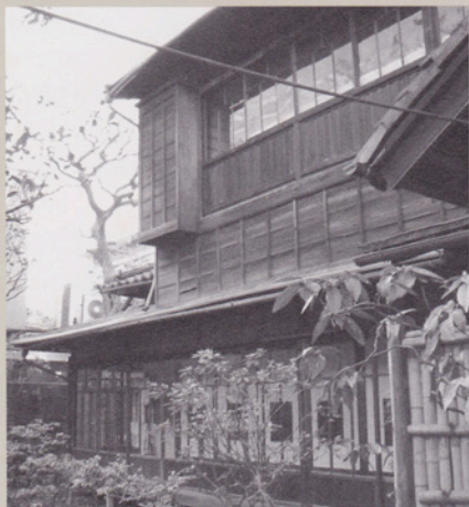
市田邸の門から建物を見る
