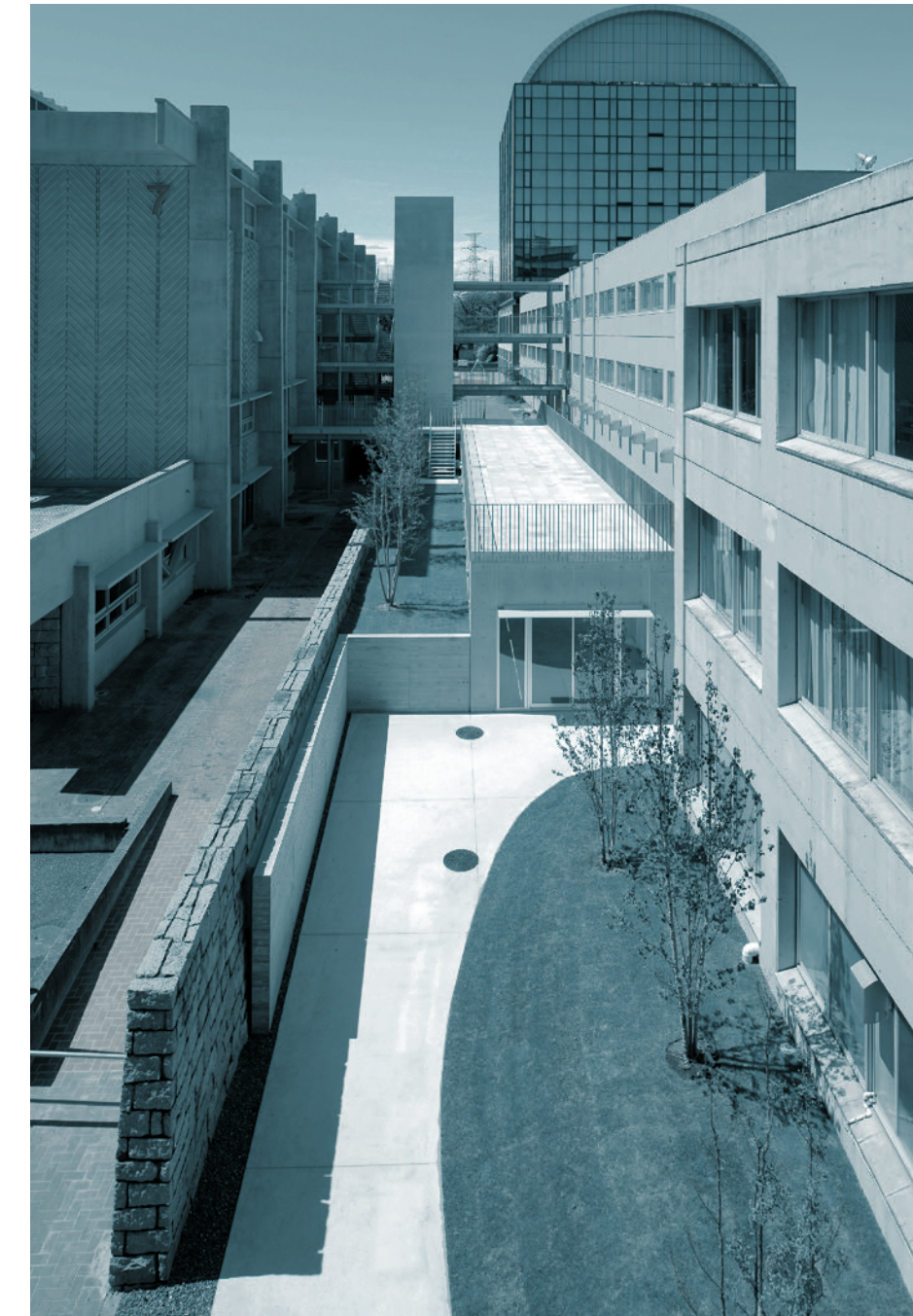
エレベーター棟・東側外観
