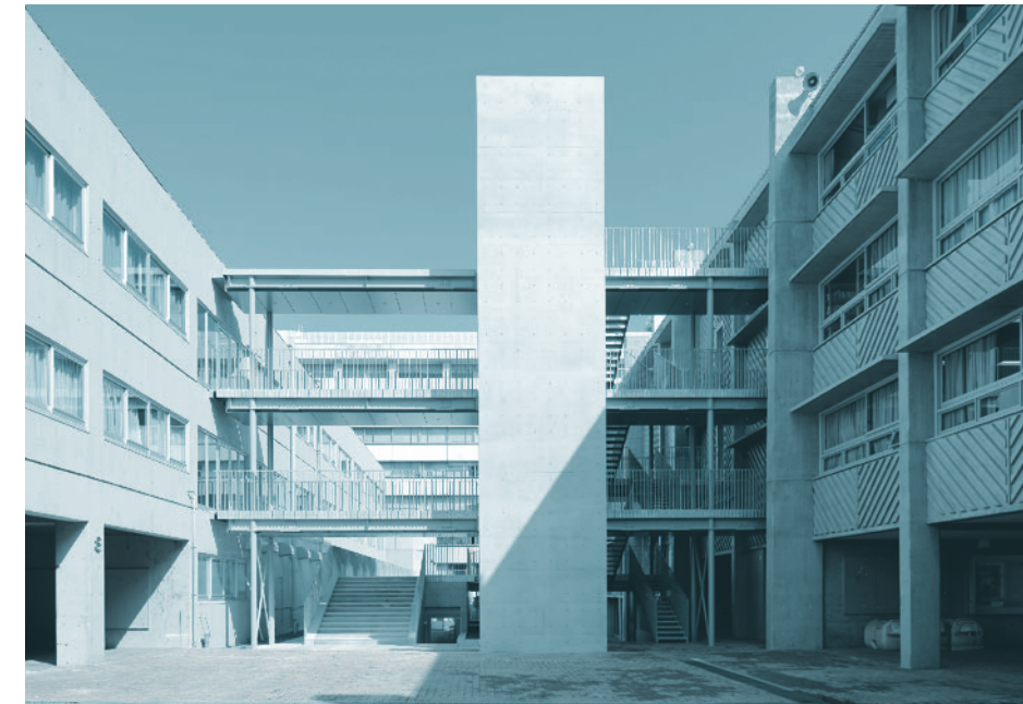
エレベーター棟・西側外観
