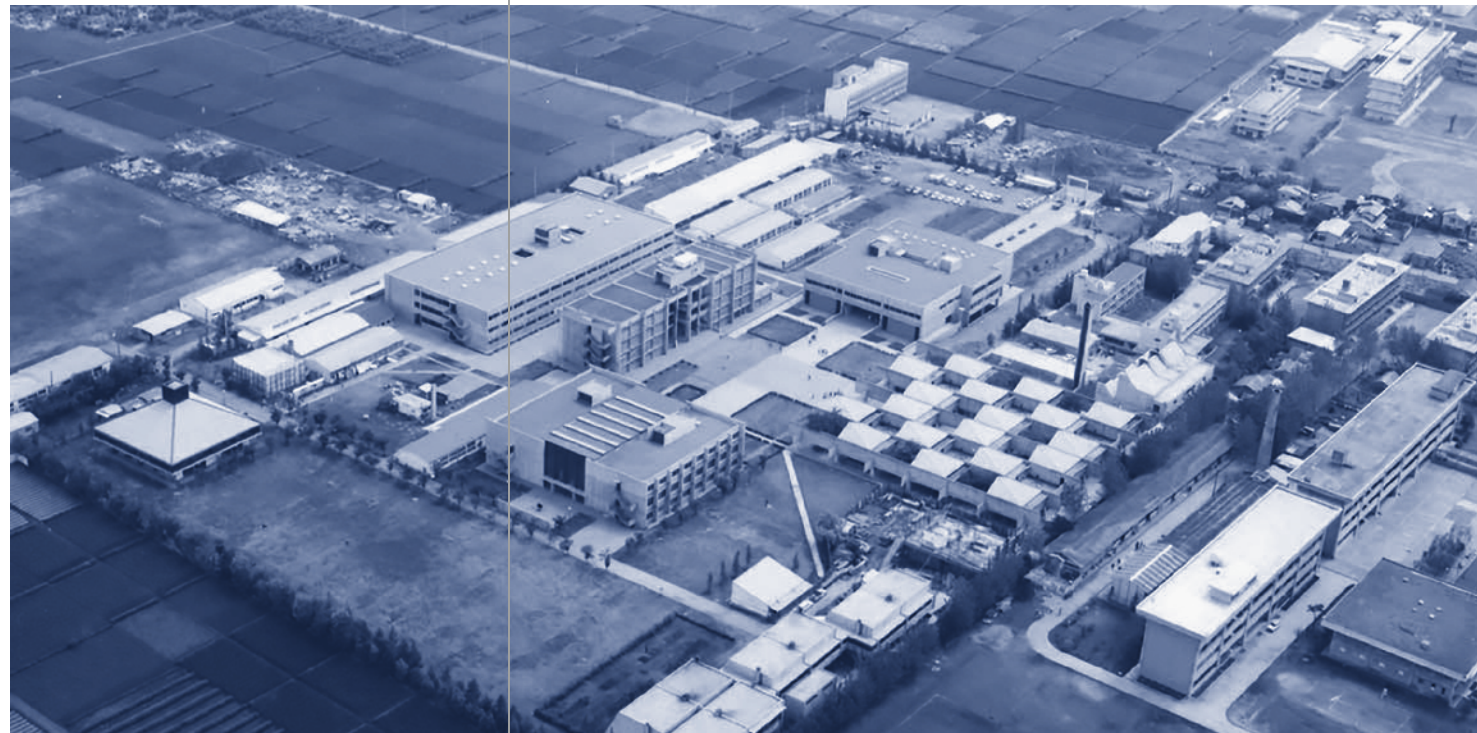
体育館建設が始まった武蔵野美術大学キャンパス。
